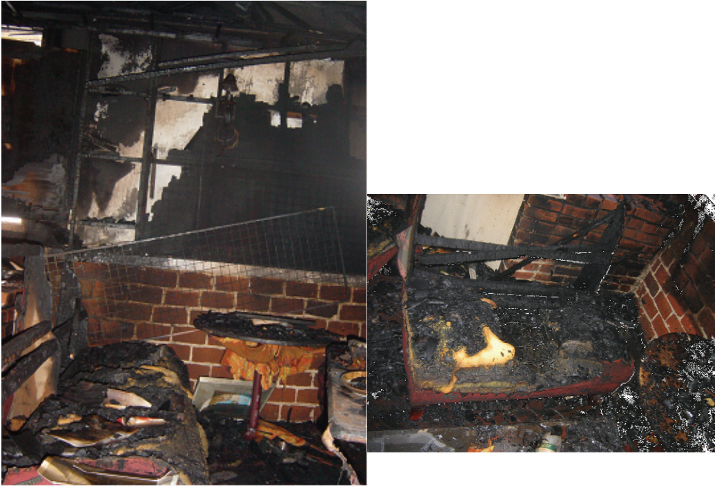
[사진 29] 무염연소 후 화재로 진전되어 나타난 V-shaped Pattern
