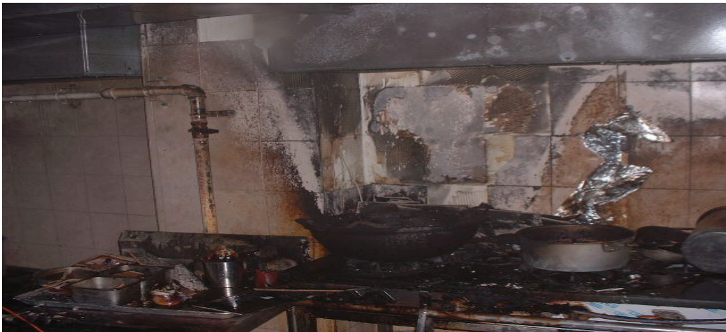
[사진 30] 식용유과열로 인해 발생한 화재의 예 12)
