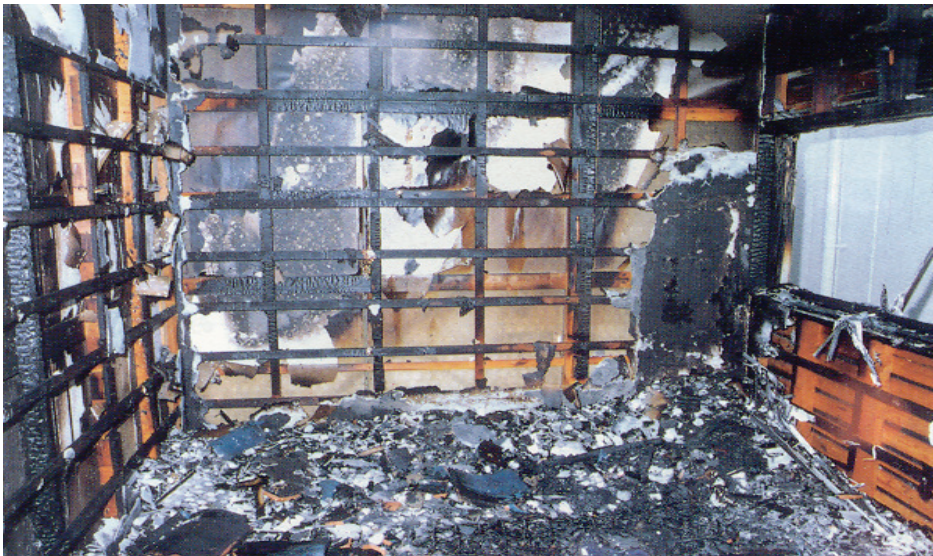
[사진14] 내벽 - 좌측 안쪽의 하부 부근으로 부터 화염이 올라갔음이 확인된다.
