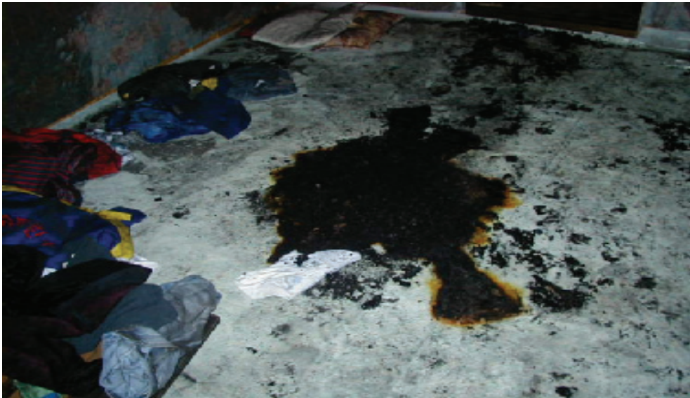
[사진 41] 연소촉진제의 살포에 의한 바닥의 소손상황 16)
