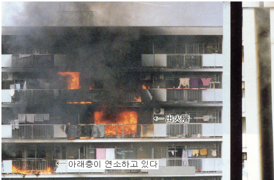
[사진 9] 연소확대 중인 건물
