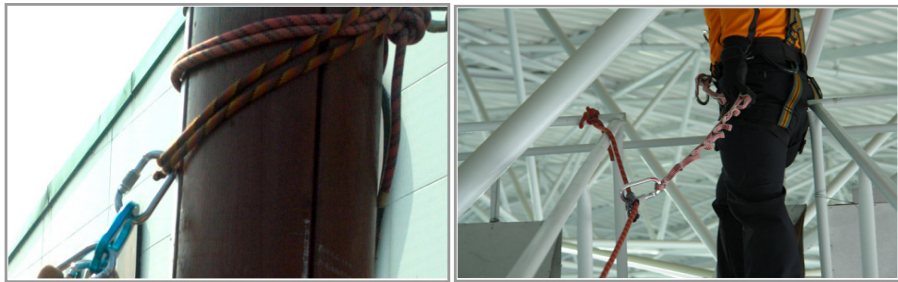
[그림 4-56] 확보로프 [그림 4-57] 안전줄을 이용한 자기확보
