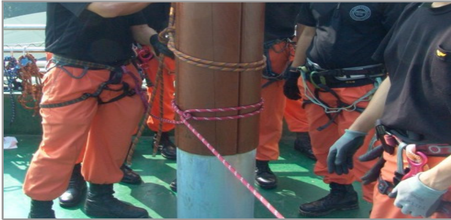
[그림 4-155] 가로로 설치된 안전확보로프
