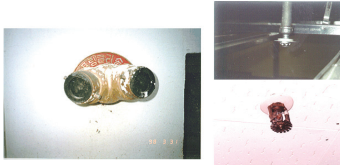
[스프링클러 송수관 및 헤드의 설치 예]
