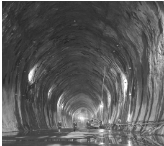
[그림 126] 암반탱크의 내부 구조
