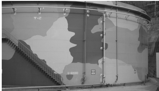
[그림 55] 물분부설비의 설치 예
