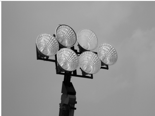
※ 조명등 점등, 파손 여부 확인
