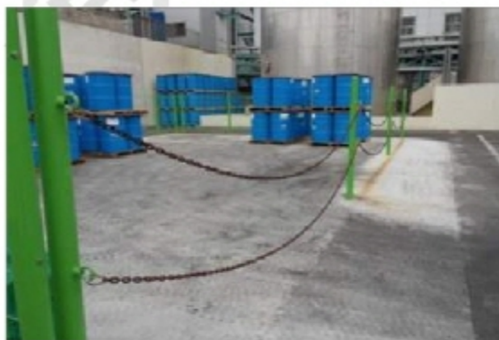
[집유설비 미 설치 예시]
