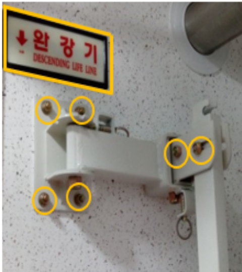
<설치 및 체결 상태 확인>
