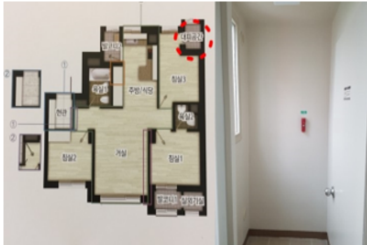
<대피공간 방화문 설치 >
