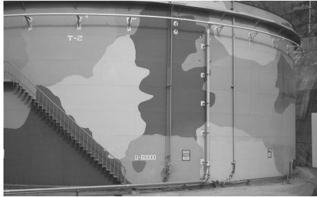
[그림 1-50] 물분무설비의 설치 예
