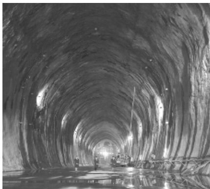
[그림 1-128] 암반탱크의 내부 구조
